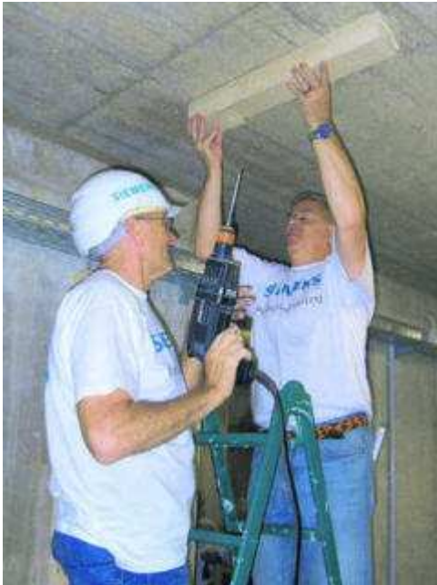
Mit Bohrmaschine und Holz werkeln für die neue Zwischenwand im Keller der Regenbogenschule: Michael Pausinger (links) und Andreas Hermann von der Firma Siemens Postautomatisierung. Bilder: Schutzbach Foto:
